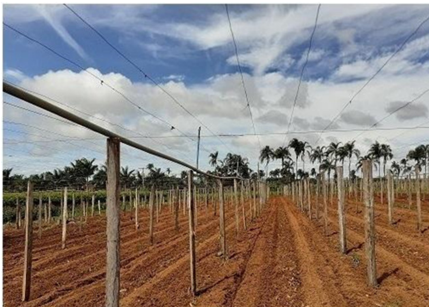
Figura 05. Estrutura em construção.
