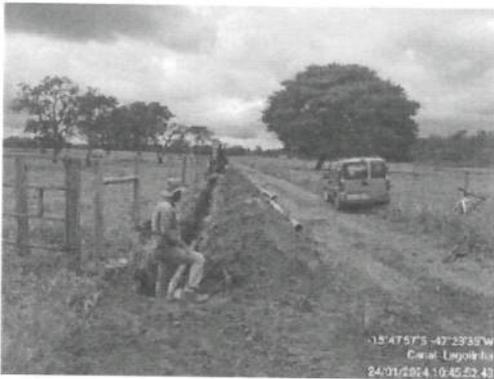
**Figura 56. Instalação de tubulação no trecho do canal Capão Comprido I**
