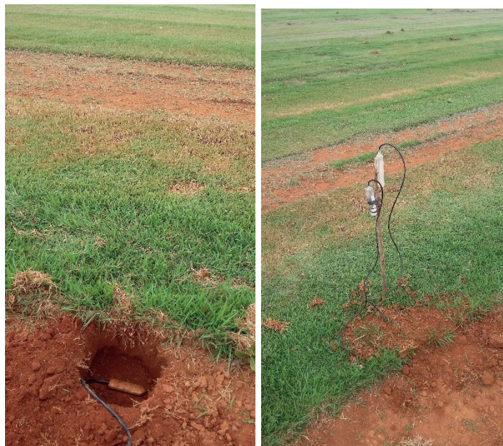
Figura 4. Instalação dos IRRIGAS® na área de gramados, grama esmeralda.
