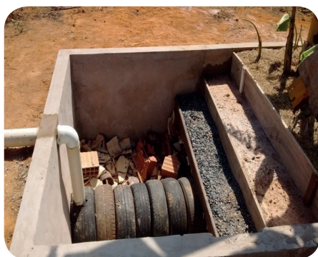
Figura 3. Câmara de fermentação anaeróbica
