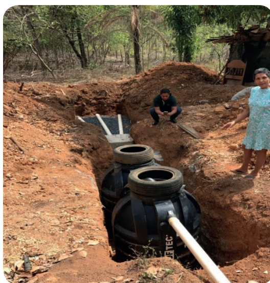
Figura 2. Filtro anaeróbico
