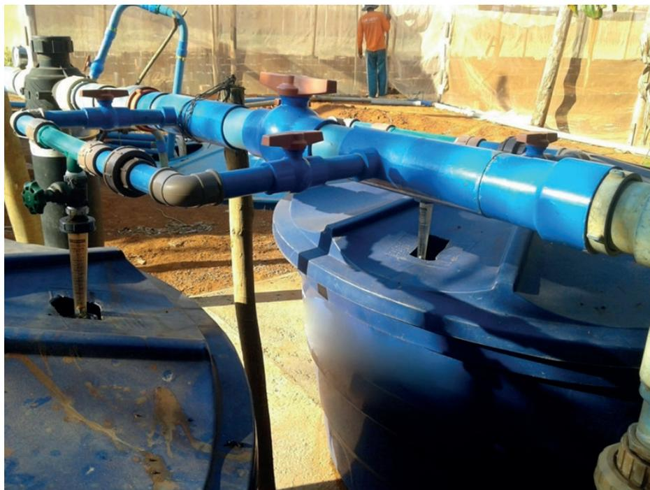
**Figura 35.** Cabeçal de injeção com duplo venturi e dosadores de fluxo (rotâmetro).
