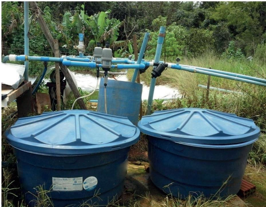
**Figura 34.** Bomba injetora de baixa vazão.
